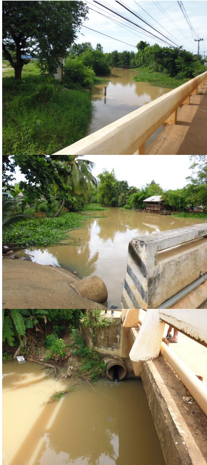
รูปที่ 1.4 การปล่อยน้ำเสียลงคลองท่าชะ โดยไม่ผ่านระบบการบำบัดน้ำเสีย
