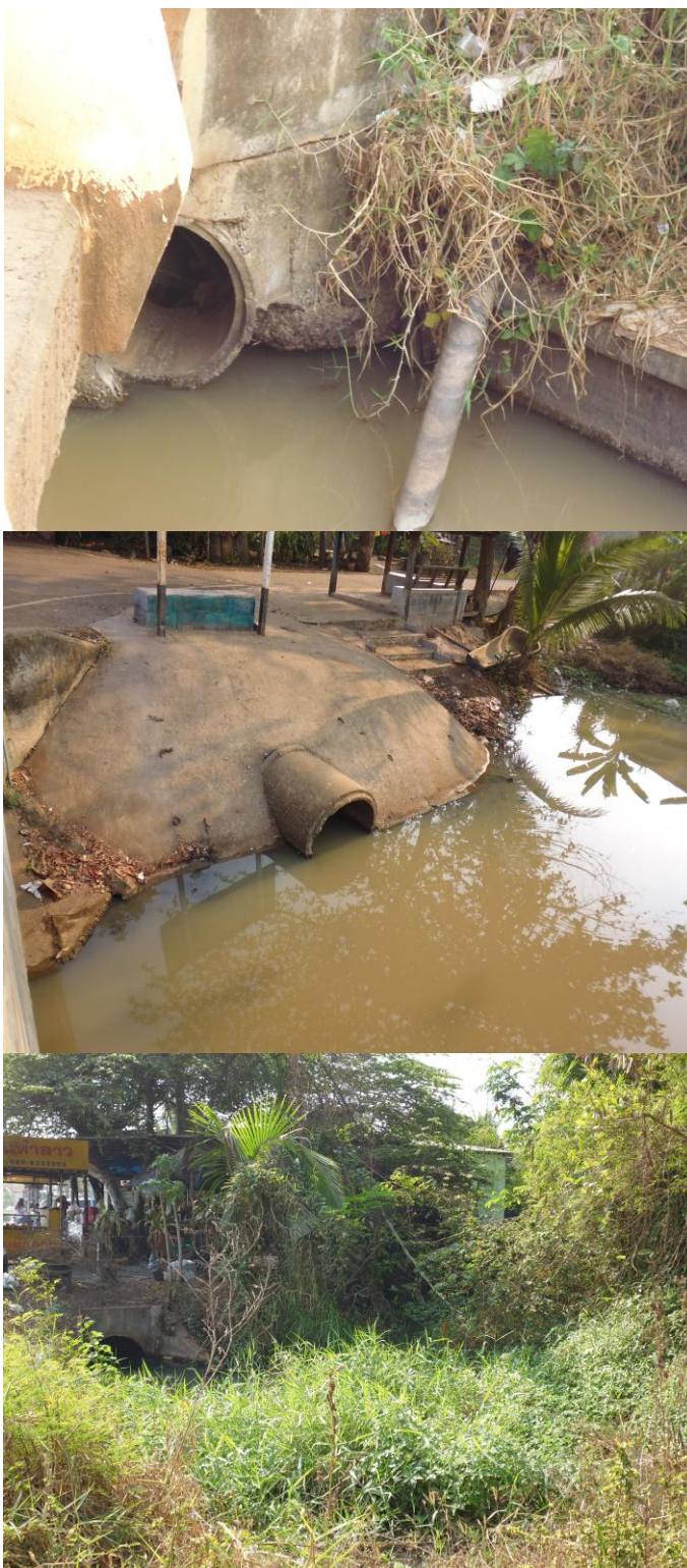
รูปที่ 1.5 การปล่อยน้ำเสียลงคลองลำแจะ โดยไม่ผ่านระบบการบำบัดน้ำเสีย
